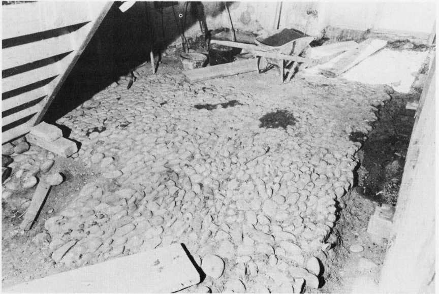
Bei der Renovation kam der alte Küchenboden aus dem 15. Jahrhundert zum Vorschein.
