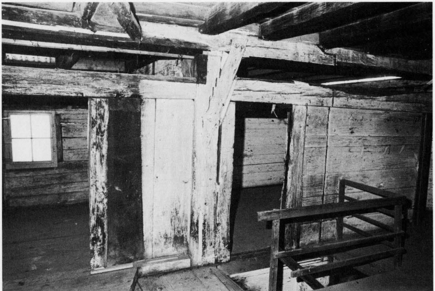
Deutlich sichtbar ist über der Zimmertüre die ehemalige Russtili.
